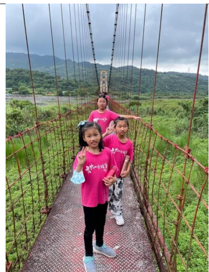
認識寒溪吊橋
