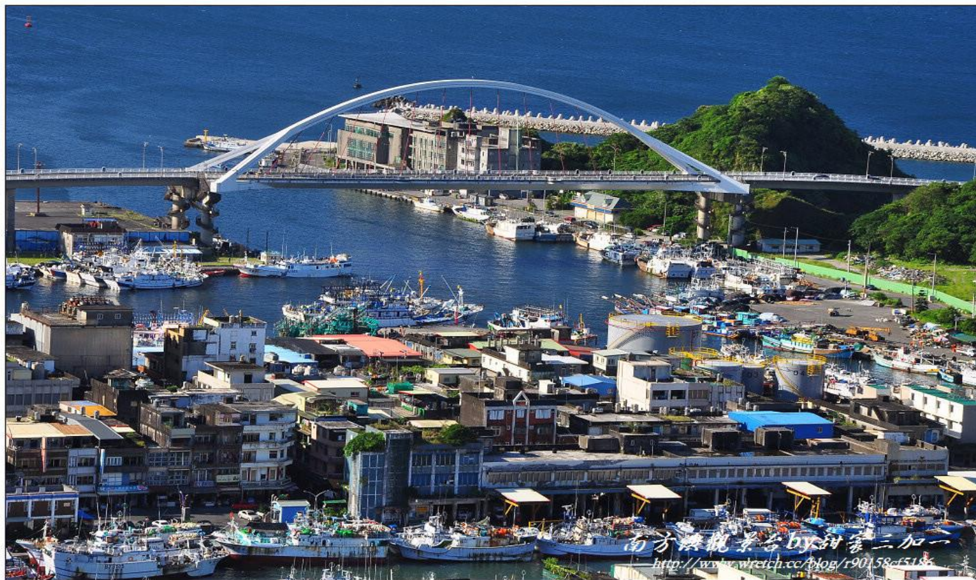
南方澳跨海大橋
